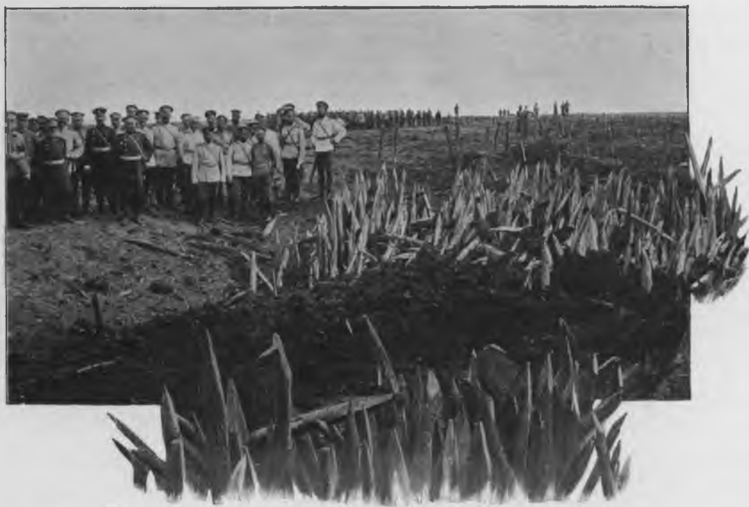
Загражденіе изъ кольевъ, частью разрушенное взрывомъ динамитныхъ патроновъ. Вдали проволочныя загражденія. Группа съ ген. Линевичемъ.
