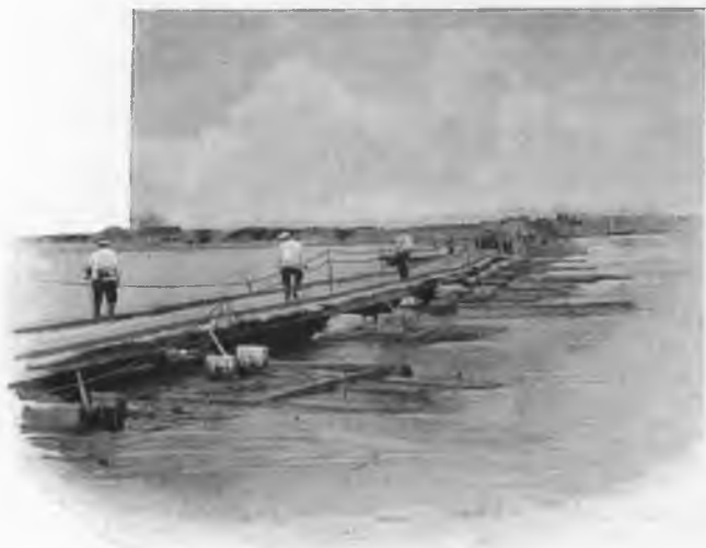
Устройство периль на мосту.
