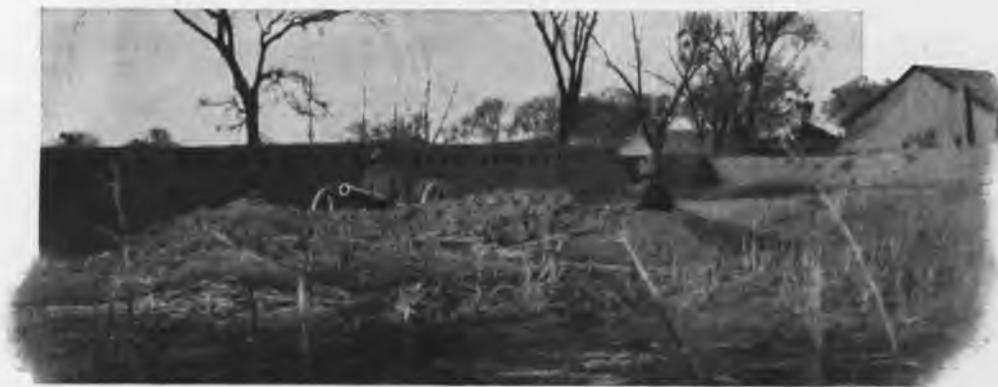
Одинъ изъ окоповъ на позиціи въ д. Чжанжуанцзы, гдѣ батарея приняла бой 16 февраля 1905 года.
