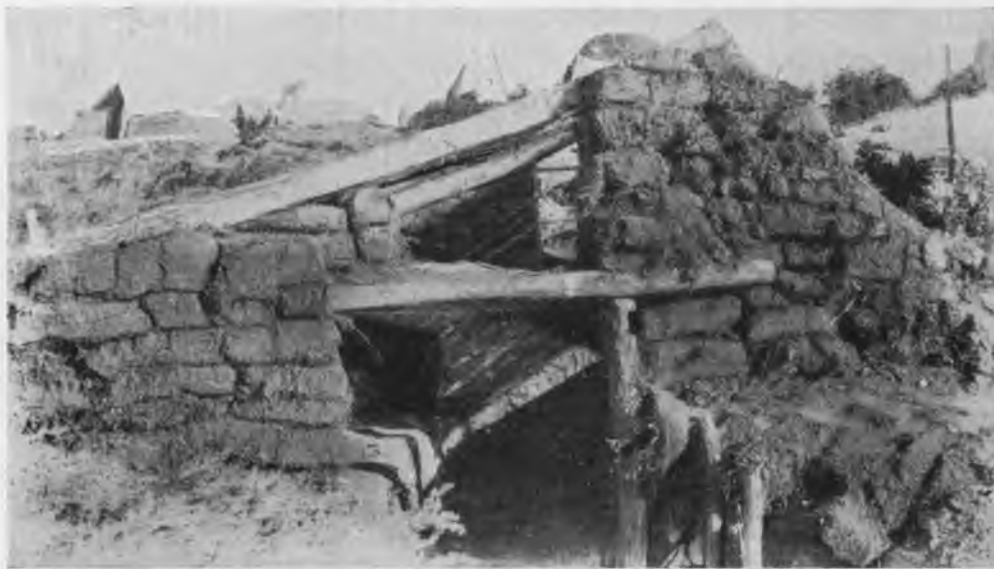
Разрушенный крытый ходъ сообщенія.
