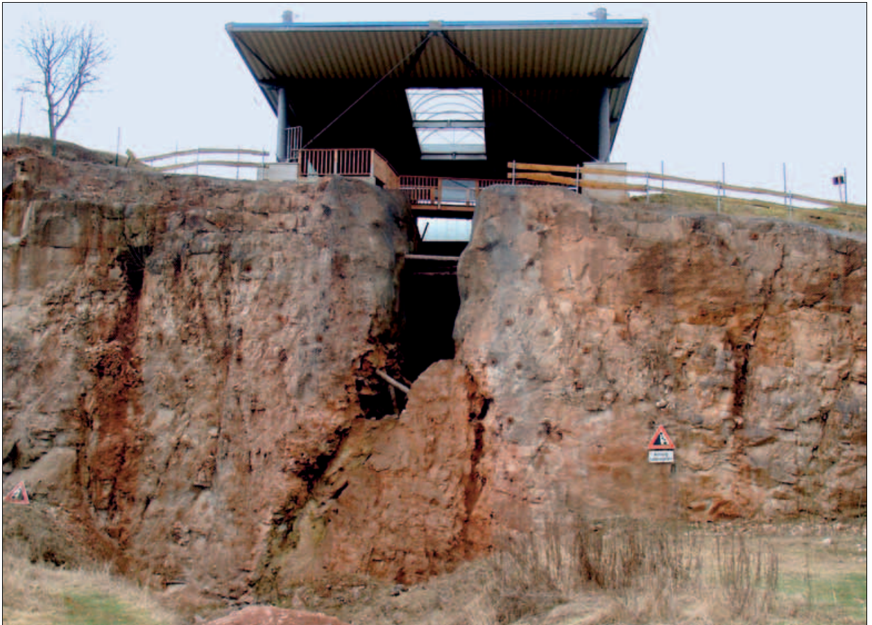
Abbildung 5 Die Korbacher Spalte im Frühjahr 2003
